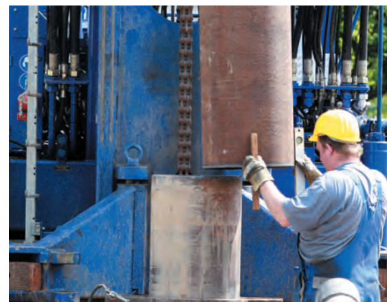
Mitarbeiter beim Einbau einer Rohrtour
