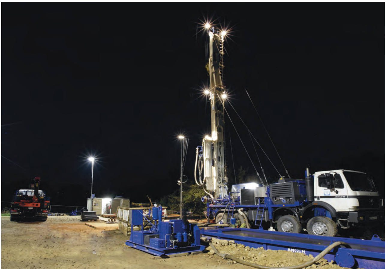
Bohrarbeiten im Zweischichtbetrieb
