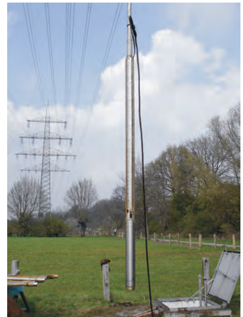
Ein- und Ausbau von Unterwasserpumpen
