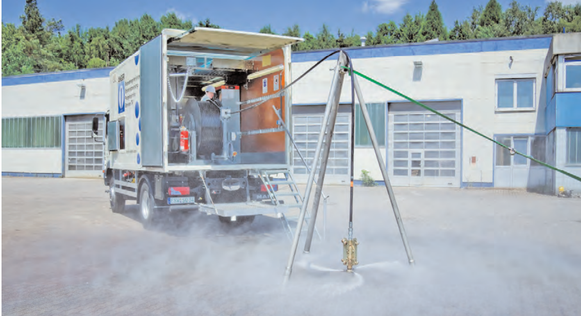
Anger's mobile Wasserhochdruckanlage mit bis zu 350 bar Druck
